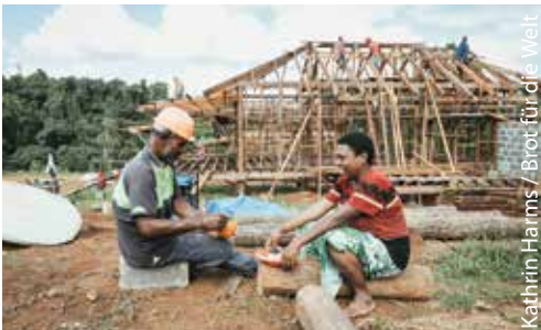
Pause auf der Baustelle (20.10.2024)
