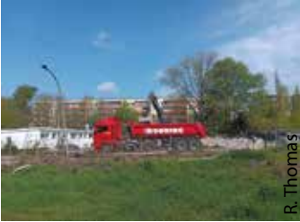
Abriss der Garagen und „Kameltränke“
